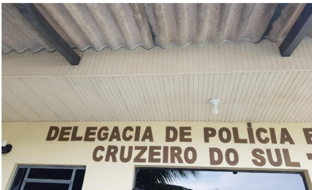
Figura 5: Forro em pvc encardido e ressecado.
