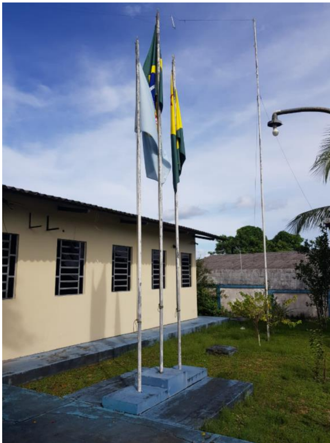
Figura 11: Mastros deteriorados e sem fixação.
